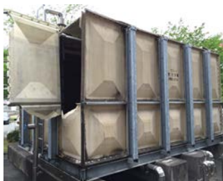
写真 1 隅角部上部側板の破損事例 (FRP タンク, 熊本市南区)
