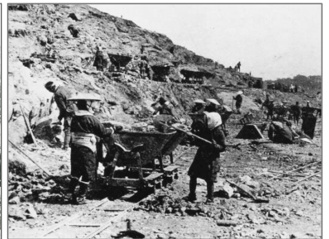
2000 台が使用された人力の土運車トロッコ、通称“鍋トロ”
