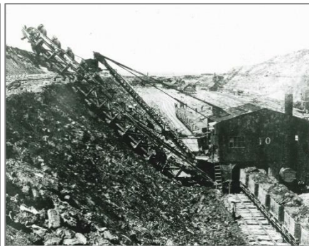
斜面を削りながら移動していくドイツ製のエキスカベーター
