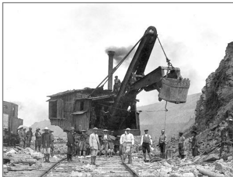
岩盤掘削機械としてイギリスから輸入されたスチームナビー
