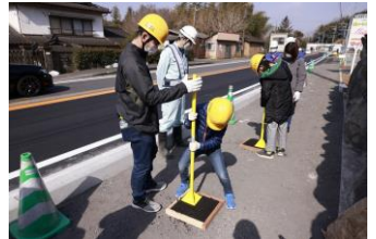
アスファルト舗装体験☆
