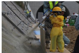
モルタル吹付体験☆
