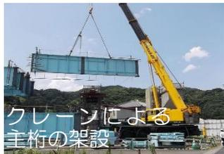
(左の写真)。現場で組立てた若しくは予め組立てられた上部工を、橋台・橋脚に載せる工事のことです。この架設工事にも様々な工法があります。
