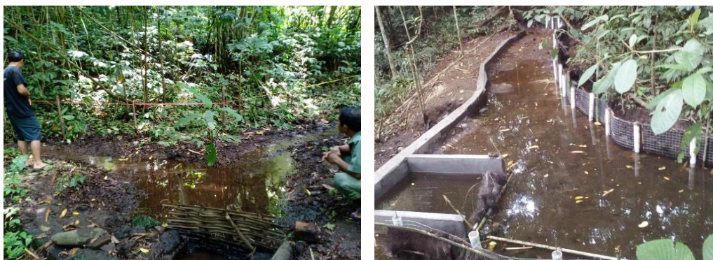
▲水源工事実施前（左）と実施後（右）
