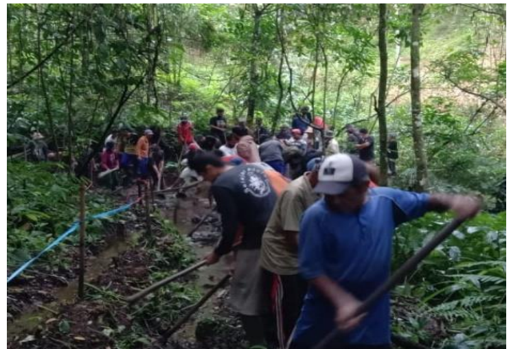
▲ゴトンロヨン（村民参加）による給水工事
