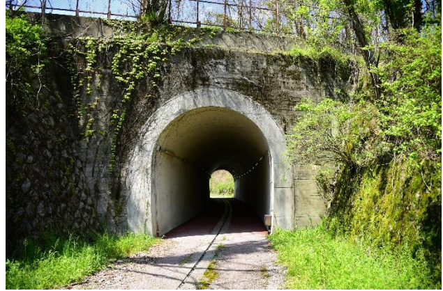
トンネル②：弥高川の下をくぐる
