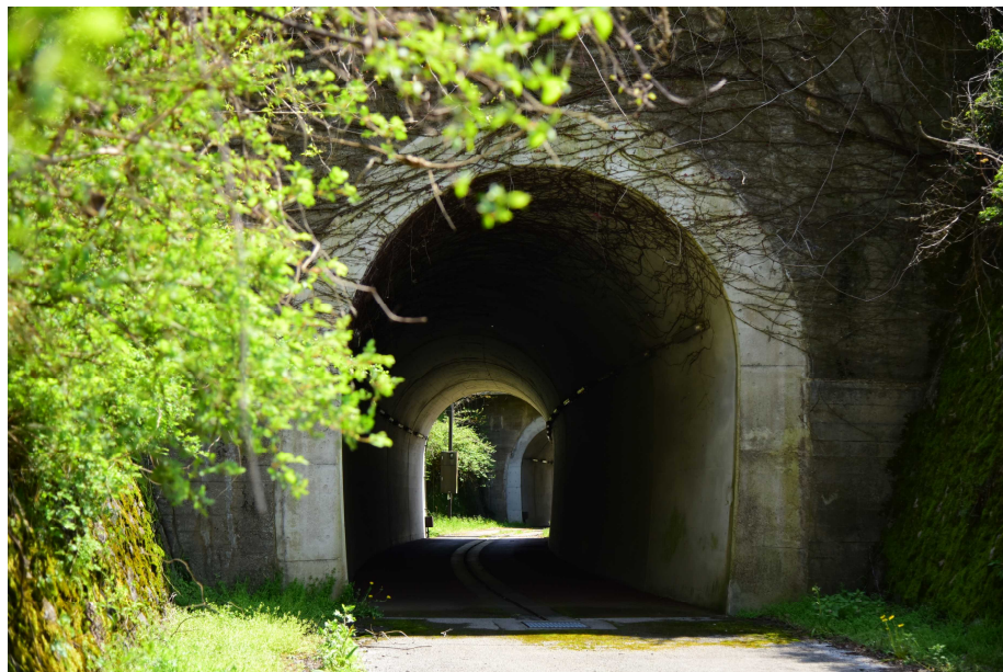
●手前は天井川下のトンネル・奥は国道下のトンネル
