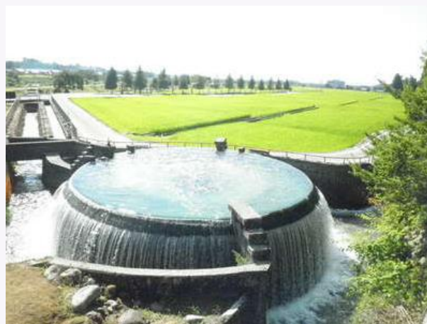
写真-4 東山地区円筒分水（魚津市）
