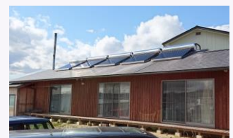
7kw 太陽光パネルと9基の太陽熱温水器を寄贈・設置した登米市の「手のひらに太陽の家」
