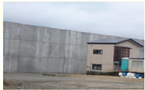
二階建仮設より高い海岸堤防(宮古 16.4 塩入)
