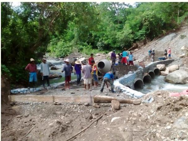
写真1 沈下橋建設状況（フィリピン）
