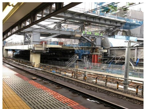
写真 渋谷駅改良工事
