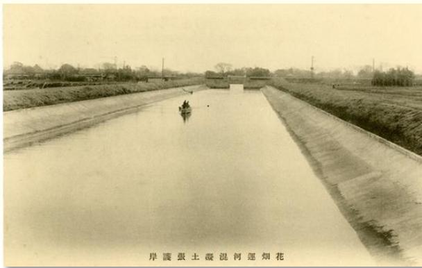
写真-1 昭和7年「花畑運河混凝土張護岸」
