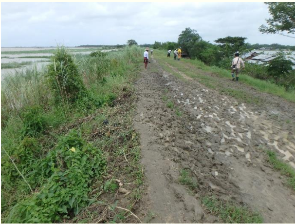
写真3 堤防天端の道路（雨季の様子）
