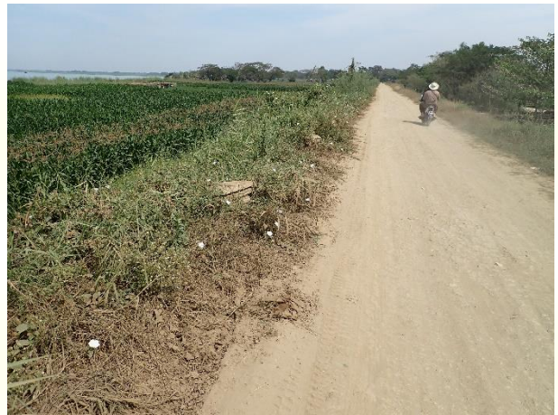
写真6 堤防天端の道路（乾季の様子）
