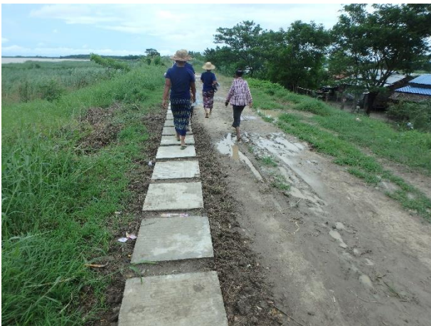
写真5 堤防天端に設置されたコンクリートパネル（雨季の様子）
