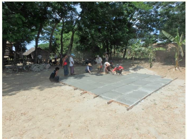
写真4 コンクリートパネルの作成
