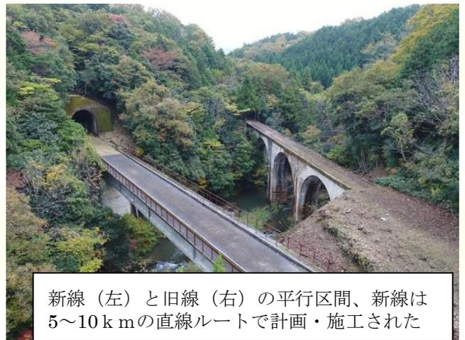
新線(左)と旧線(右)の平行区間、新線は5~10kmの直線ルートで計画・施工された
