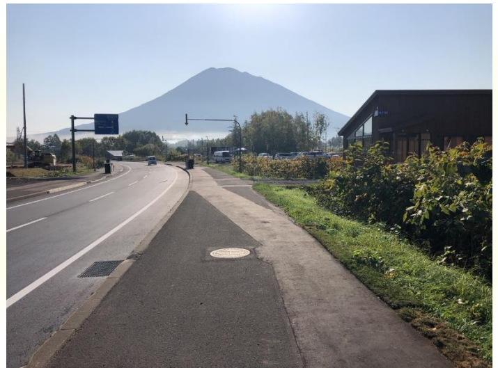
倶知安町ニセコの無電柱化工事完了後
