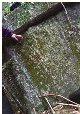
写真10：長野隧道 (廃) 反対側は埋もれて 要石がこんな位置に！
