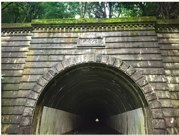
写真3：観音坂隧道（閉鎖）・・・村田鶴
