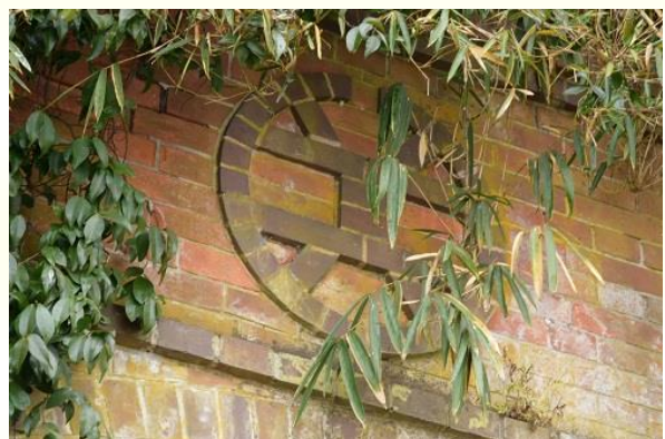
写真8：国分橋梁のパラペット部にある関鉄の社紋
