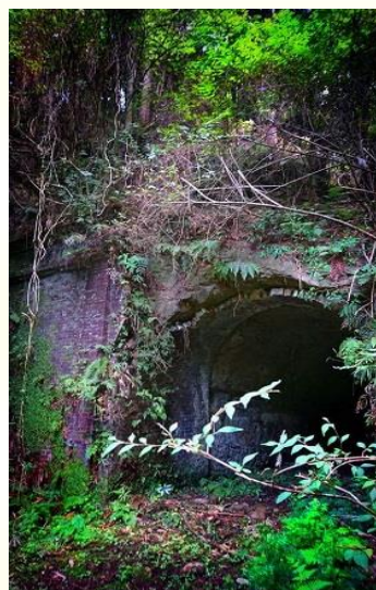
写真2：奥山田隧道 裏(旧道側)から
