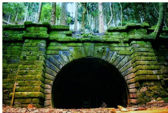
写真9：長野隧道（廃）三重県
