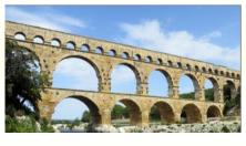
力)だけが作用するという特徴があります。その ためにローマの水道橋では石積みのアーチ橋 が延々と続いています。古いトンネルの覆工に レンガを積んだものもあります。これは全て部材 に圧縮力だけが作用するので可能な構造です。
