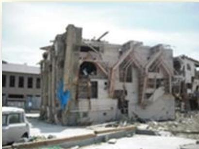
写真-1 液状化の影響によるビルの転倒
