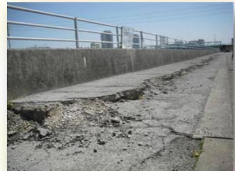
写真-2 液状化による堤防の破壊
