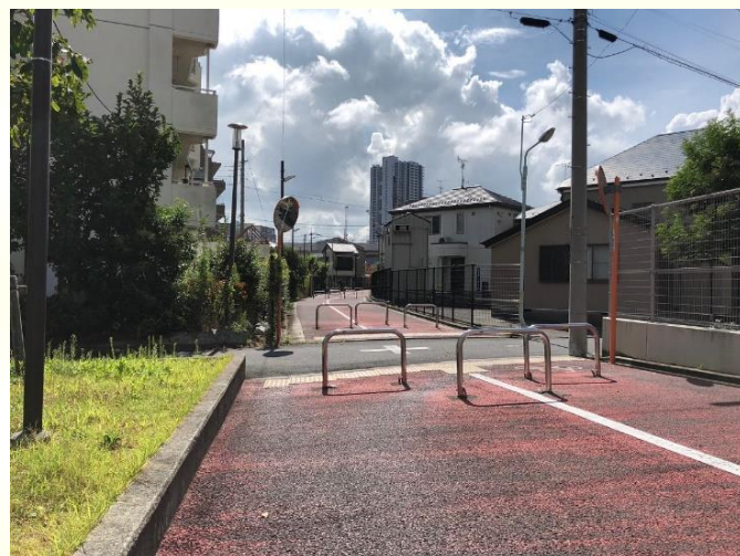
図5 引き込み線跡 金町駅と公園を連絡する道は、かつて軌道が敷設されていた。まだ土木遺産を構成する要素が現地には残されている。
