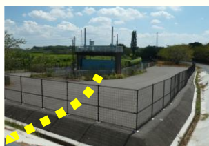
現在の柴山伏越 （上）元荒川を地下横断 （黄色の点線）している （右）伏越し下流側
