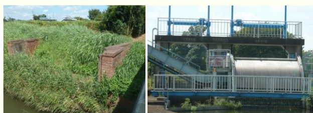
瓦葺掛渡井跡（左）と現在（右）は綾瀬川 を伏越手前の水門（東縁・西縁に分岐）
