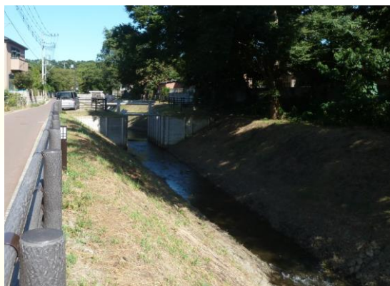
現在の見沼通船堀（東縁） ※復元された通船堀、手前が一の関先に、二の関が見える
