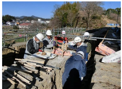
写真1 漆喰詰替え（令和元年保存修理工事時）
