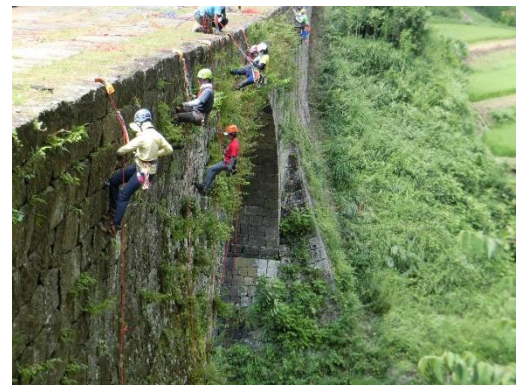
写真3 除草作業の様子 (令和2年8月)
