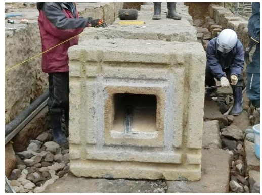
写真2 通水石管断面の通水穴と漆喰目地 (令和元年保存修理工事時)
