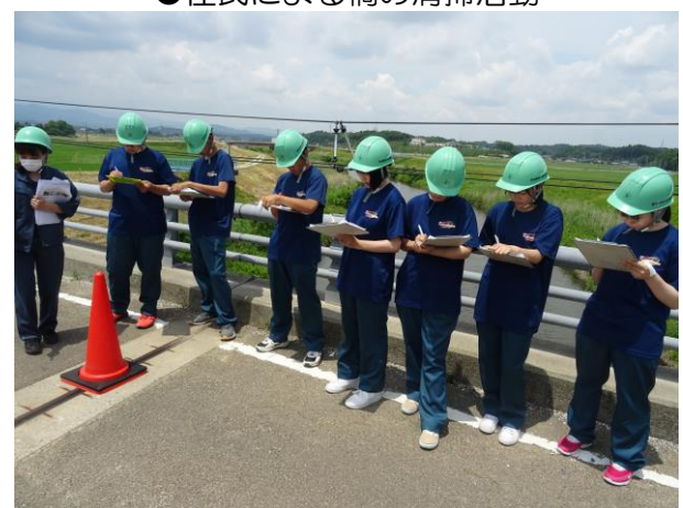
●高校生による橋の点検の様子
