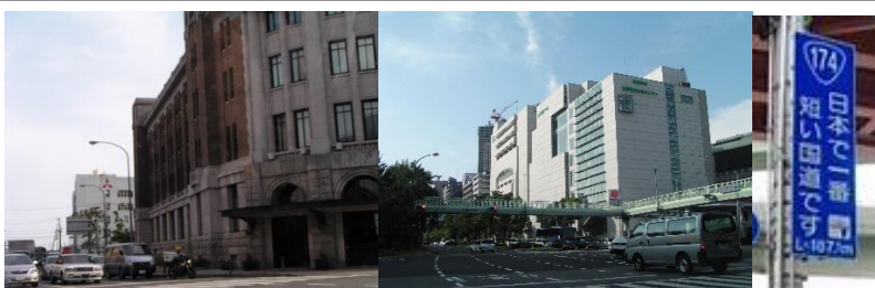
税関本庁前交差点から起点 (神戸港方面) 方向
