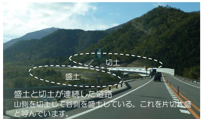
切土：地盤（地山）を掘削した構造となる。
