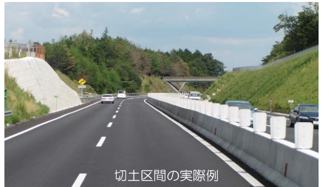
盛土と切土が連続した道路 山側を切土して谷側を盛土している。これを片切片盛と呼んでいます。
