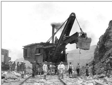
岩盤掘削機械としてイギリスから輸入されたスチームナビー
