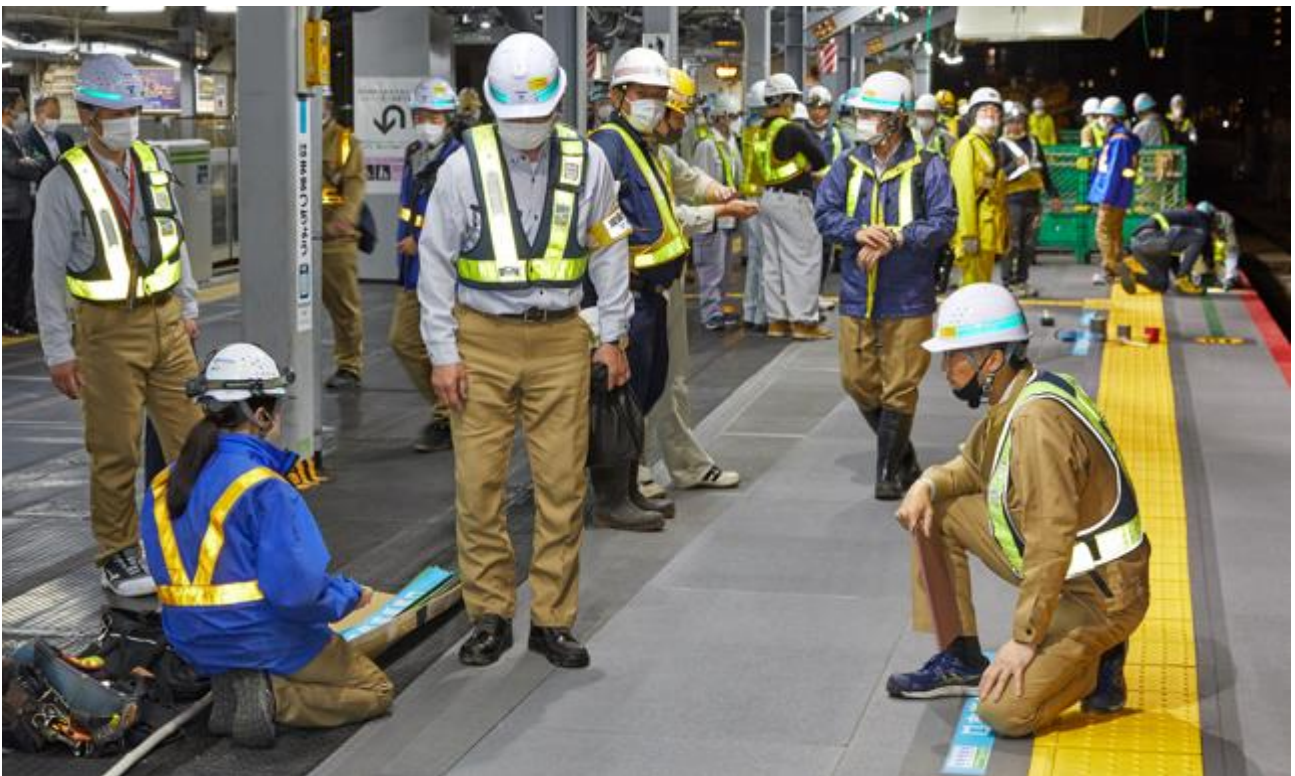
線路切換工事中 乗車位置目標の最終確認中の富永さん（左下） （撮影協力：東日本旅客鉄道株式会社）
