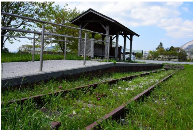
レールと駅舎モニュメント
