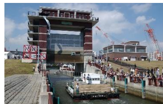
荒川ロックゲート 荒川と隅田川を結び
