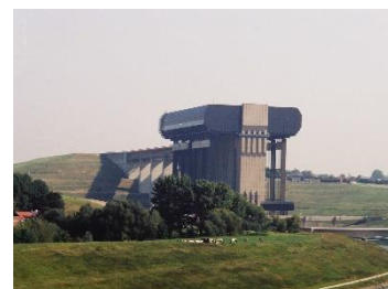
ストレティピーユ リフト式閘門
