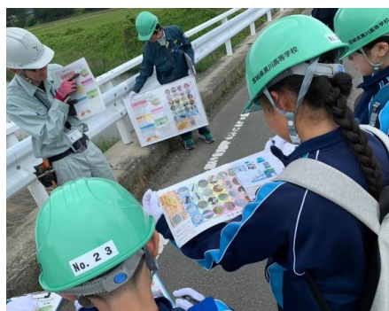
●中学生による橋の点検体験
