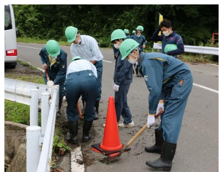
●高校生による橋の清掃活動
