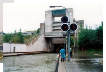
マインラインドナウ運河の閘門
