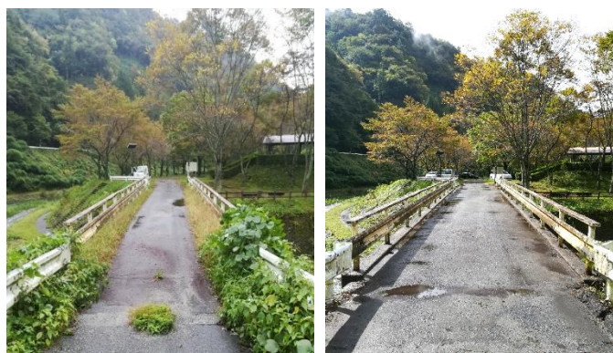
Before After 写真-4 橋守活動の前後
