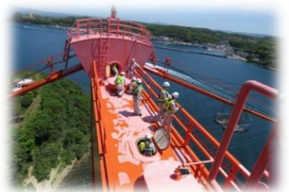
平戸大橋の点検作業
