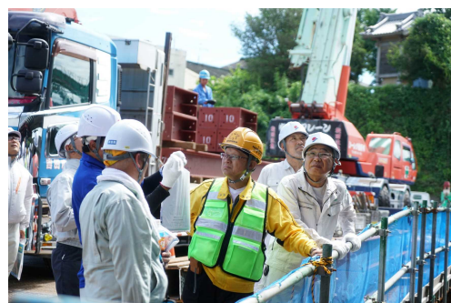
●橋梁建設現場見学会
