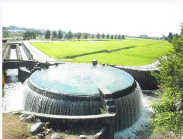
写真-4 東山地区円筒分水（魚津市）
