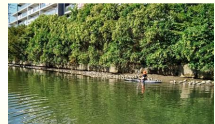
玉石積み護岸が残っていた！
