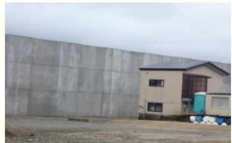
二階建仮設より高い海岸堤防(宮古 16.4 塩入)
