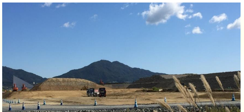
陸前高田市の仮置き土砂搬出現場(17.5)
