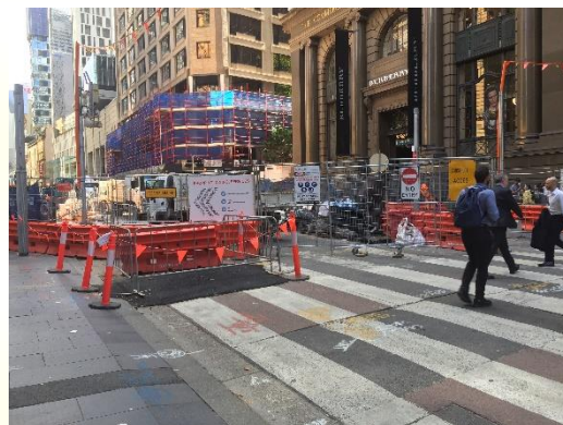
CBD の車道部を全幅占有しての路上工事
