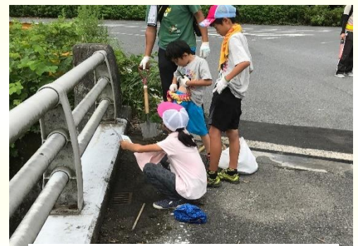
市民と共に橋を点検する
