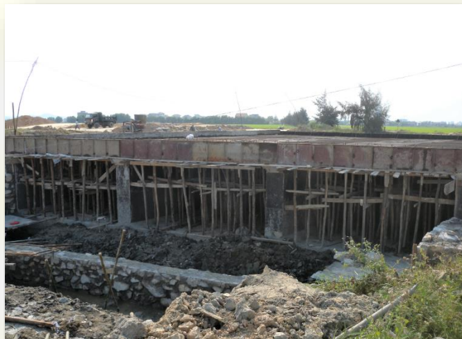
ベトナムの工事現場
