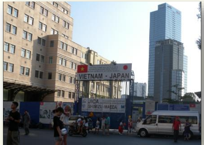
ホーチミン市の JICA 案件の地下鉄工事
