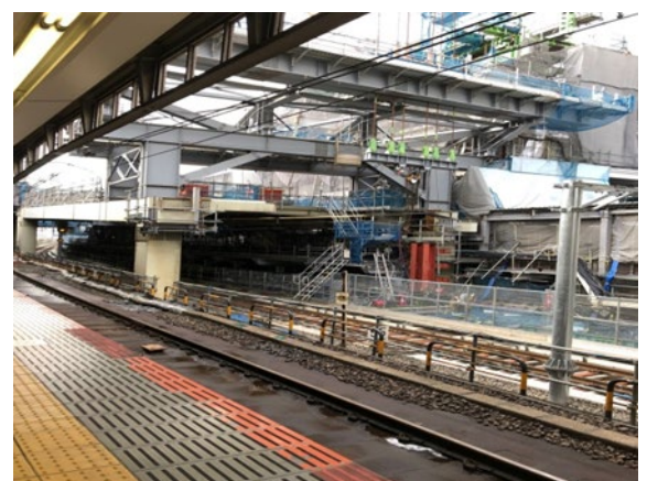
写真 渋谷駅改良工事
