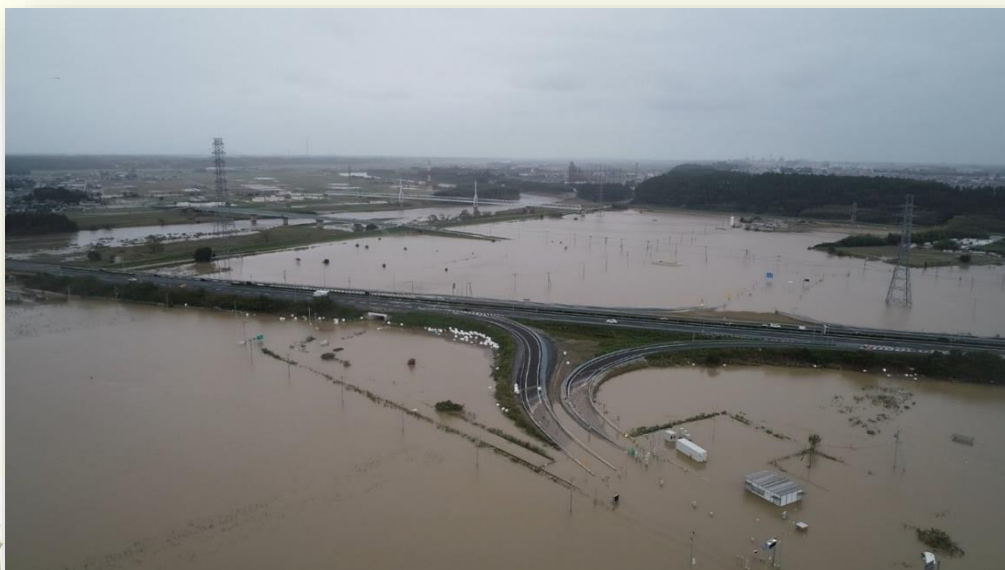
水戸北スマートIC周辺の様子（令和元年10月13日）
