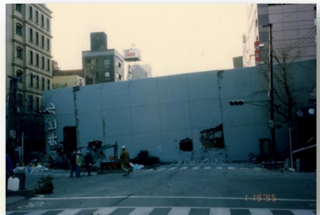
阪神淡路大震災 横倒しのビル
