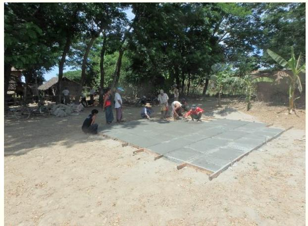
写真4 コンクリートパネルの作成
