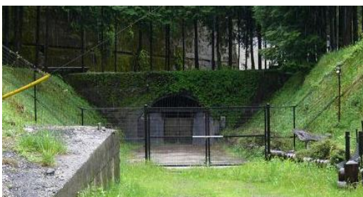
最長の三段峽トンネル(9910m)の広島側坑口の現状
