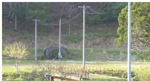
三段峽トンネルの中間地点の縦坑と仮橋(本杭は地下200m)
