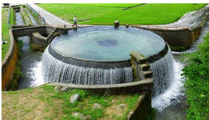
写真6 1955年完成／東山地区円筒分水槽（国登録有形文化財（富山県魚津市））
