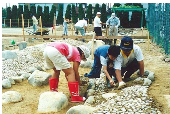
写真 親水広場の整備(農水省パンフより)
