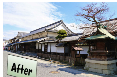
●無電柱化の施工前と後
