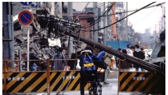
地震による電柱倒壊（神戸市長田区）
