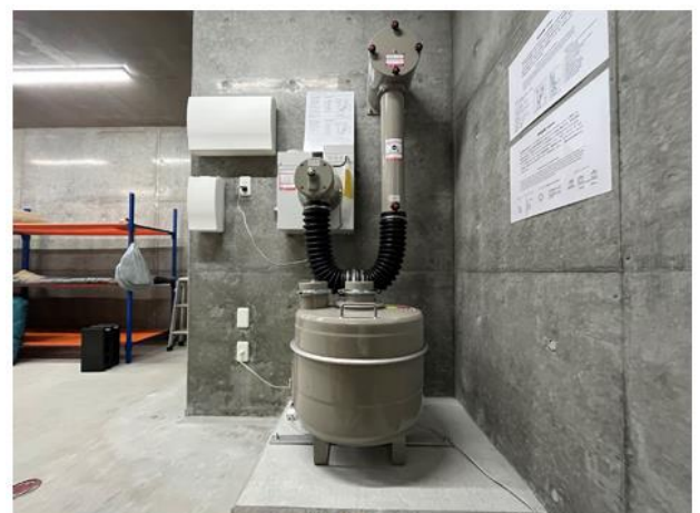
写真5 NBCR対応換気装置
