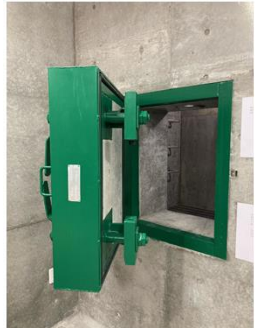
写真6 非常用脱出口
