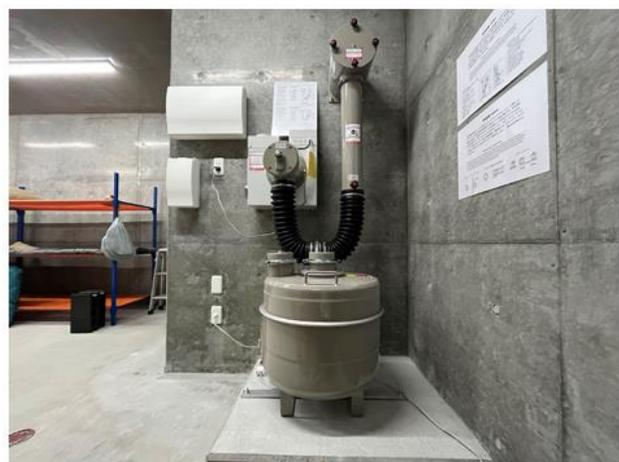
写真5 NBCR対応換気装置
