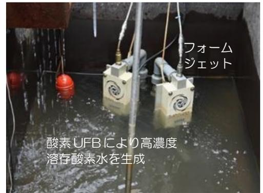
写真-5 放流水槽の酸素UFB発生装置
