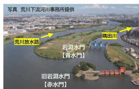
放水路分派地点の上空からの写真
