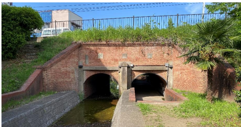
写真 1：千貫樋(現在は「千貫樋橋」)
